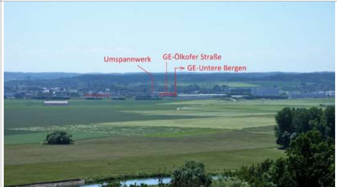
Fotostandort 1: Heuneburg (Wehrgang Ziegelmauer) mit Blick nach Süden
