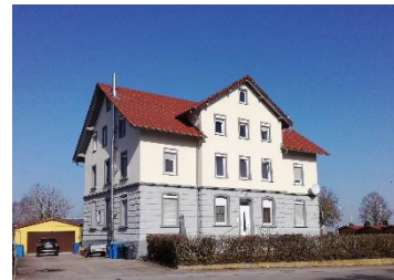
Abb. 8 ehem. Gasthof Bahnhof
